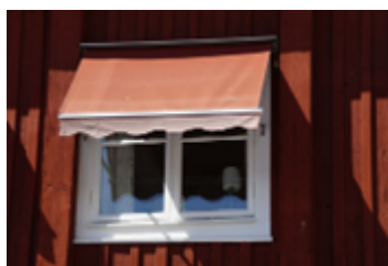
Figur 1: Fönster med markis
